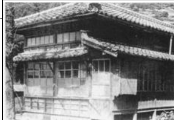
巖木小学校養護室 明治41年佐賀県最初の養護室
