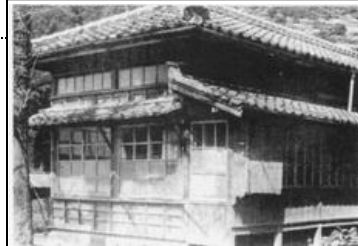
巖木小学校養護室 明治41年佐賀県最初の養護室
