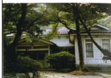
保利病院 大正7年に建った洋館風の保利病院
