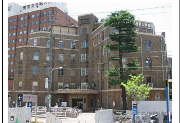
東京女子医科大学病院1号館 竣工 昭和5年（1930）12月
