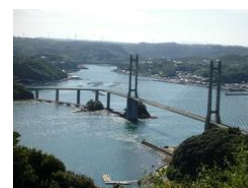
呼子大橋 （あそぼーさがHPより）
